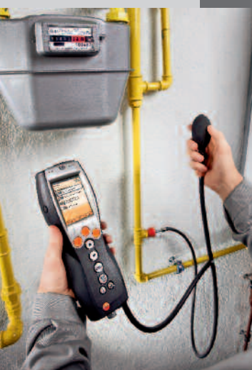
Prova tenuta impianti gas
