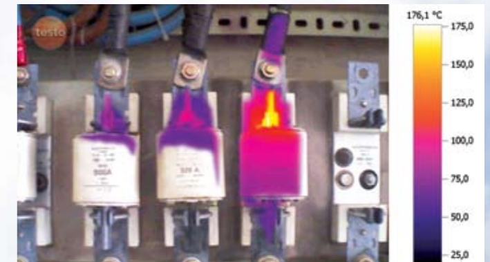
Widoczne różnice temperatur na zdjęciu rzeczywistym, dzięki funkcji TwinPix
